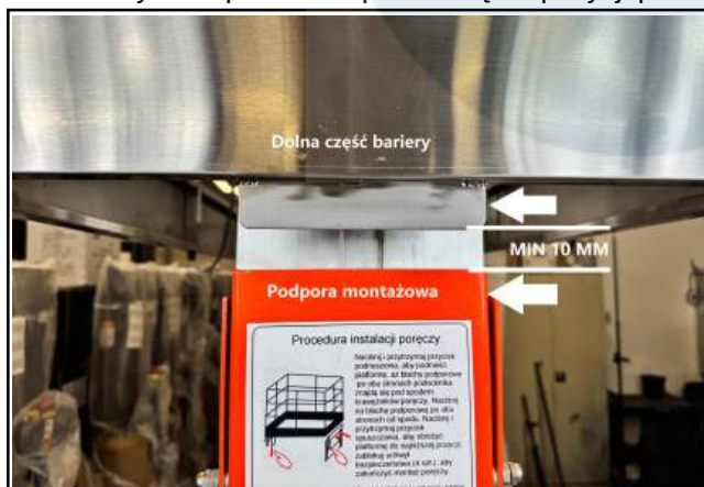
Rys.14.1 Punkty mocowania barierek
